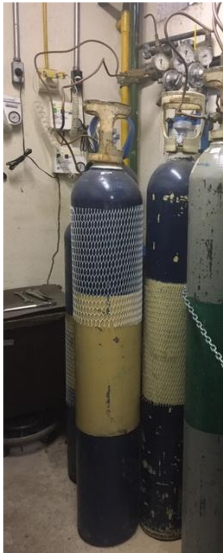
Figura 1 – Baterias de óxido nitroso, contendo quatro cilindros de 29 kg
